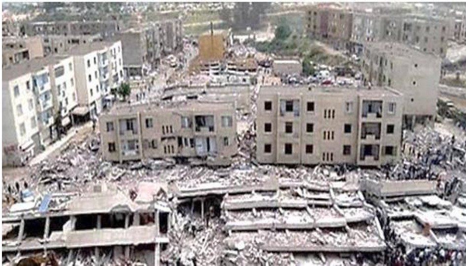
Fig.II.24. séisme du 21 Mai 2003 de Boumerdès .
