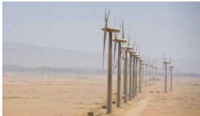
Figure I.3: La ferme éolienne de 10 MW à Kabertène (Adrar).
