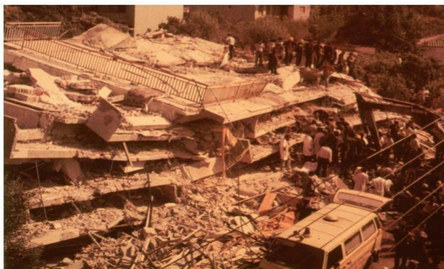
Figure 2.1: Effondrement total des constructions non ou mal contreventées.
