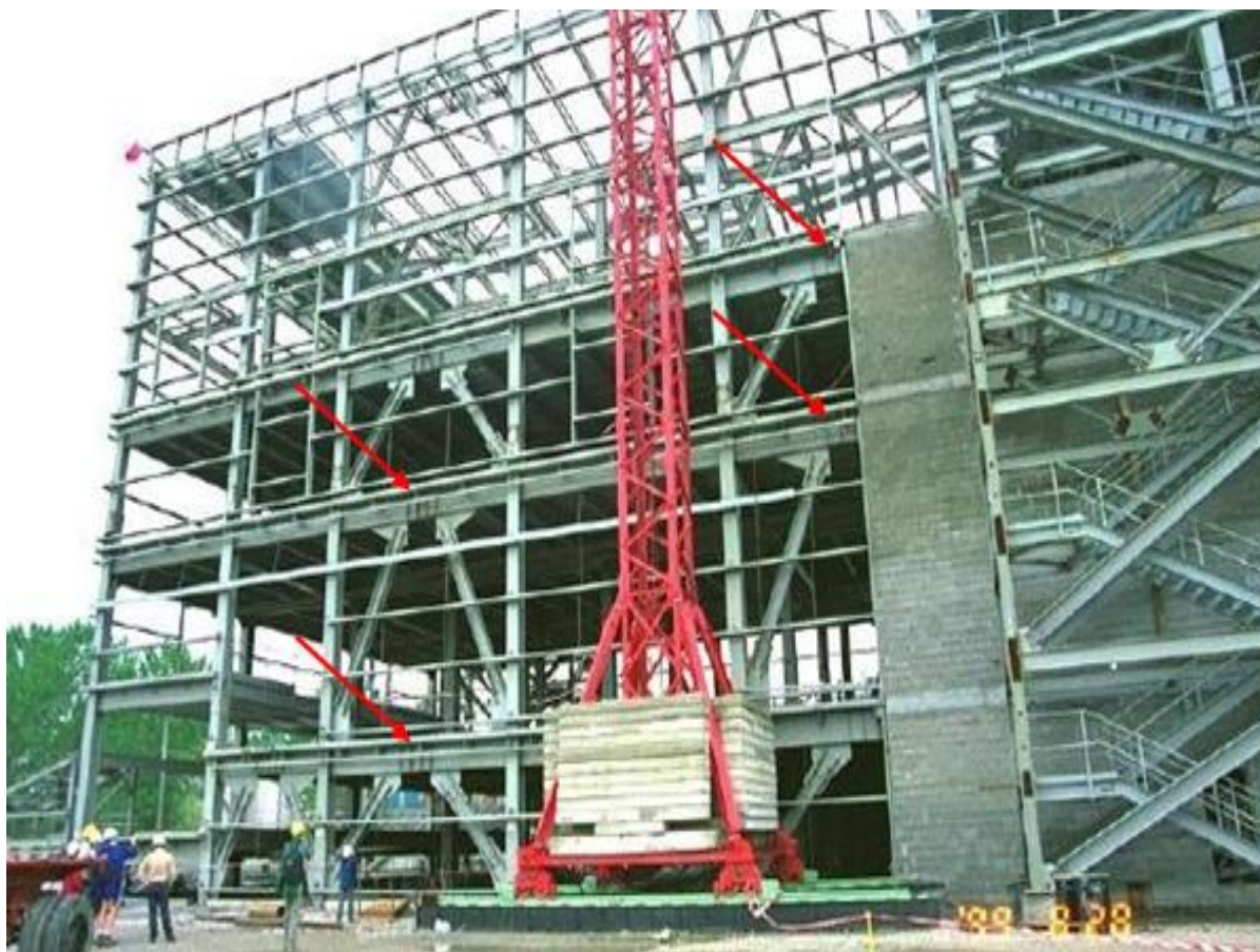
Figure 2.5 : Bâtiment avec triangulation excentrée en cours de construction(USA) [24].
