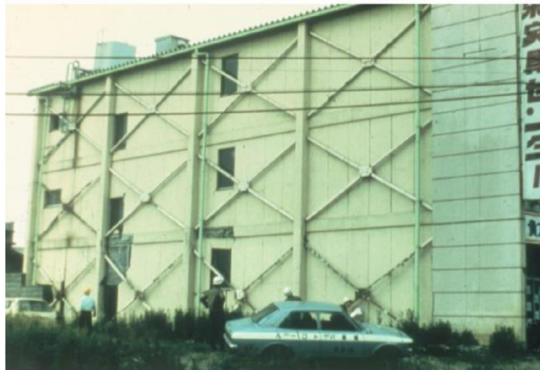
Figure 1.9 Contreventement par des barres en X.
