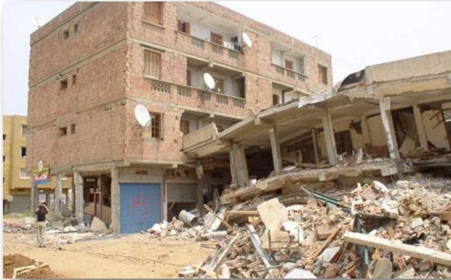
Figure 1.1 Effondrement total des constructions non ou mal contreventées : 21 Mai 2003 de Boumerdès.
