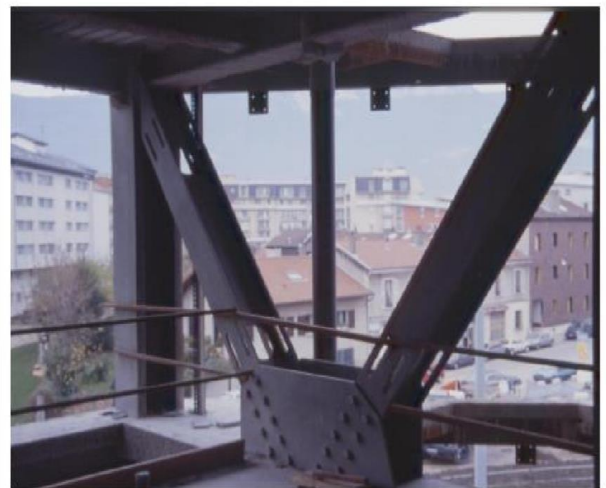
Figure 1.11 Contreventement par des barres en V
