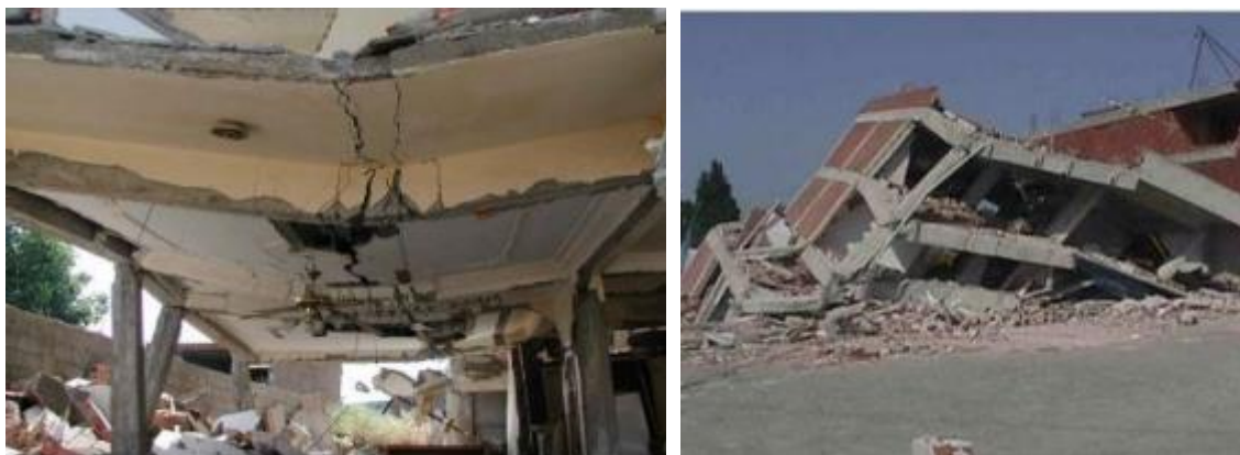
Figure 1.11 : (a) Rupture par flexion des poutres, (b) Effondrement par flexion
