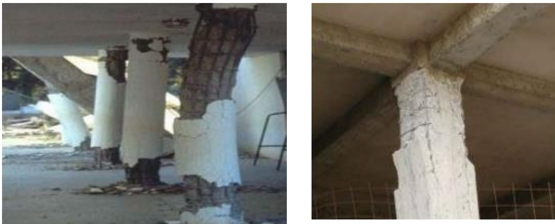
Figure 1.10: (a) flambement des poteaux, (b) Décollement de l'enrobage
