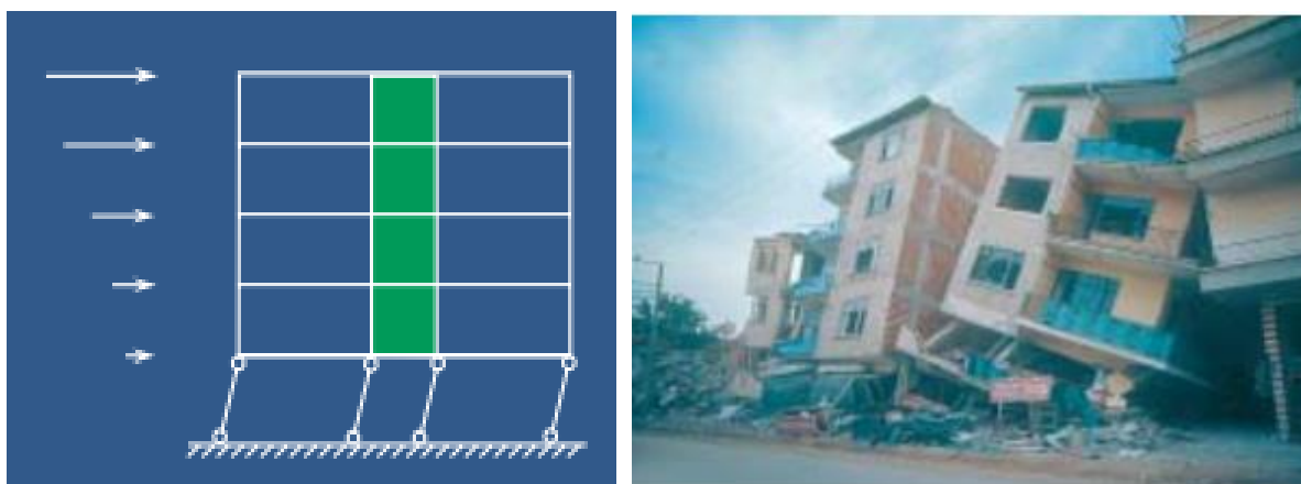
Figure 1.16 : Rez-de-chaussée flexibles (Izmit, Turquie, 1999)
