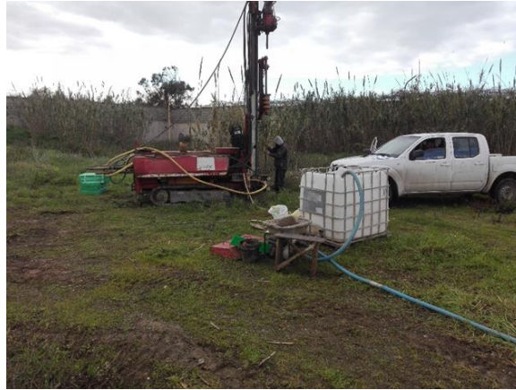
Figure 11 : photographie de la sondeuse sur le site.
