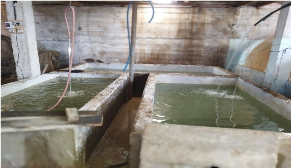
Figure 12. Photo de les 3 Bassins couvert de 3m 3 (Photo Kadri et Izouine, 2023)
