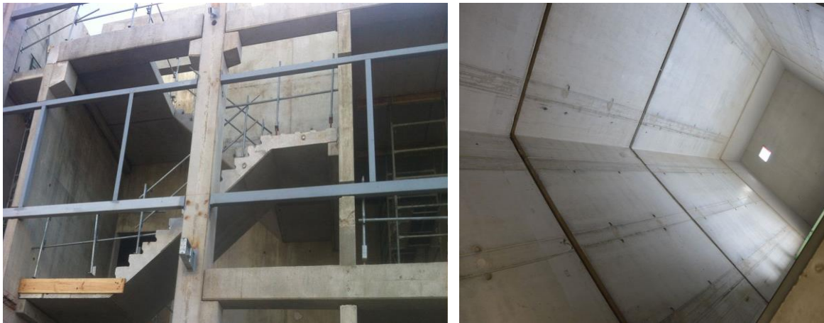
(a). Cage d'escalier en béton armé.
