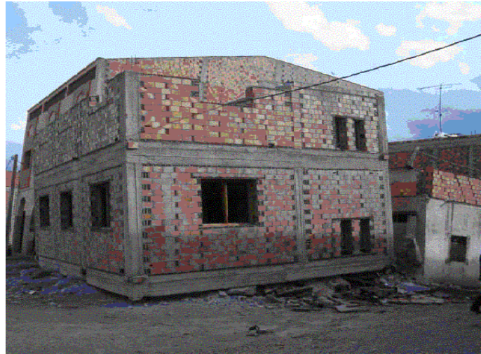
Figure 1.5. Contreventement par maçonnerie.
