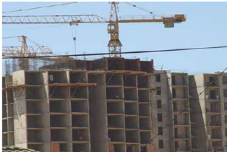
Figure 1.3. Contreventement par voiles en béton armé.
