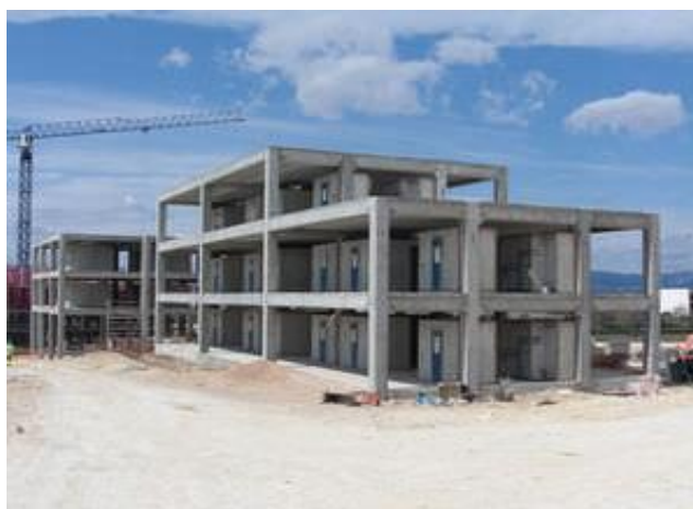
Figure 1.1. Ossature en portiques en béton armé.
