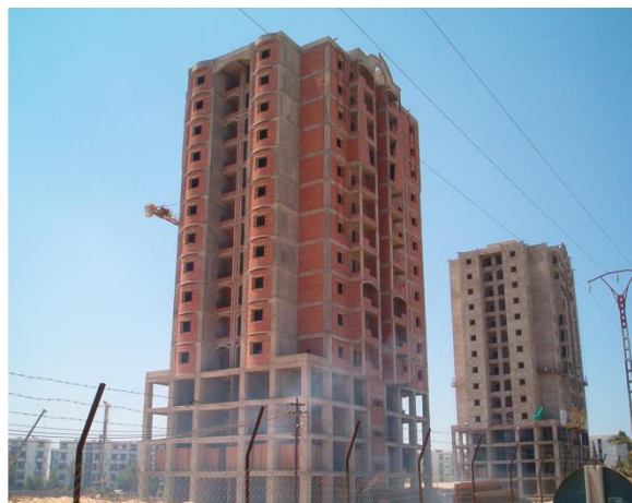
Figure 1.7. Contreventement mixte d'un bâtiment.
