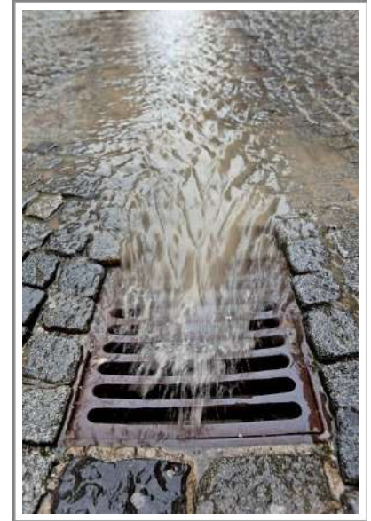
Figure 06 : Eaux usées de type pluviales
