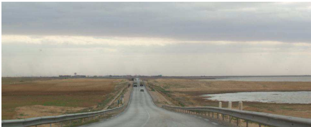
Fig. I.2 Barrage de Boughzoul. On observe le risque d'inondation de la route. [1]
