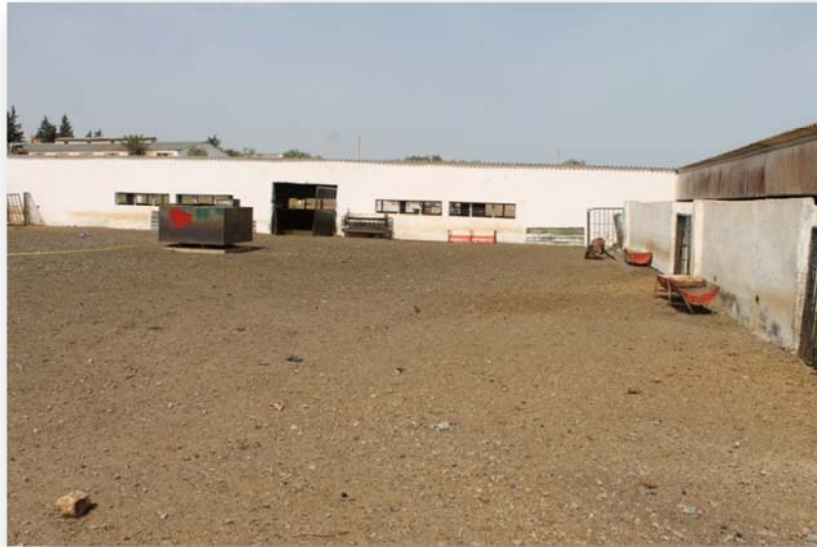
Photo 6 : Ferme pilote SI ACHOUR
