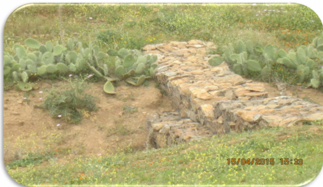
Photo 08 : technique des seuils en grillage métallique, Localisation : sidi Messaoud commun de Djelida du BV de Harreza, (cliché : LACHMI, HADI ; 2015)
