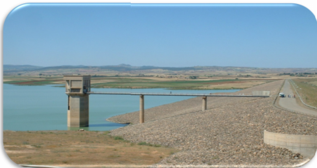
Photo 01 : barrage de Harreza
