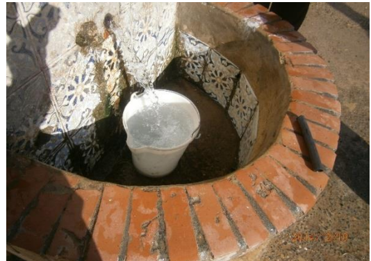
Photo 2. Captage de la source de Djendel
