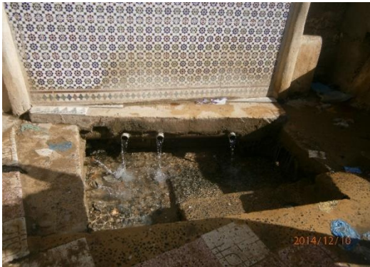
Photo 1. Captage de la source de Zougala
