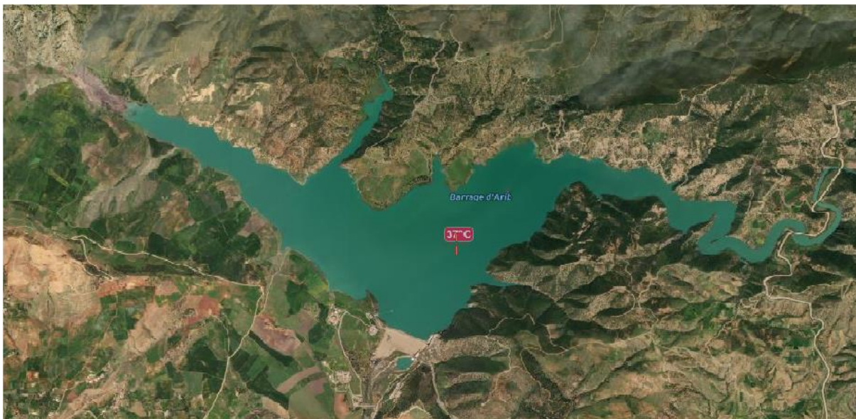
Figure 1:vue du barrage de Sidi M'Hamed Ben Taïba (Google earth,2021)
