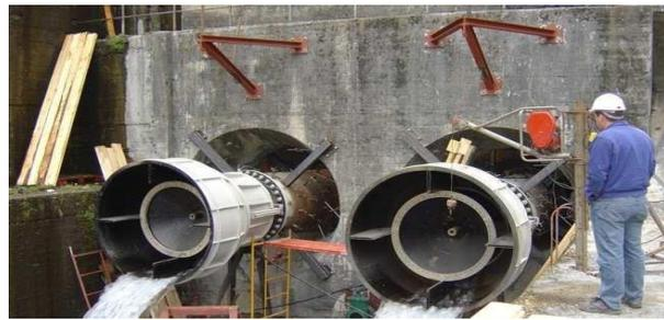
**Fig.29** Vannes à jet creux
