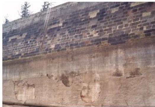
**Fig.43** Vue du parement amont dégradé du Grand Mur (BETCGB 2005)
