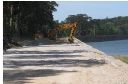
**Fig.50** Décapage de la terre végétale et mise en place du remblai
