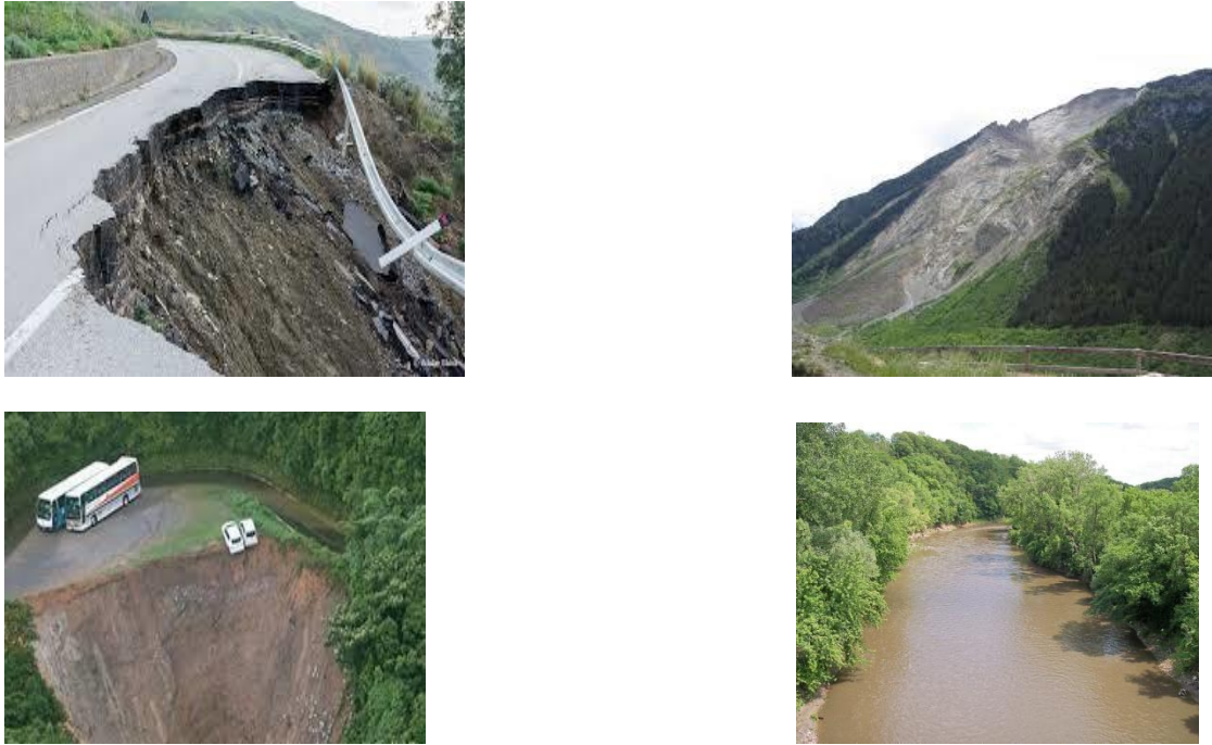
Figure 1.1. Glissement de terrain, les berges de cours d'eau ou de retenues.
