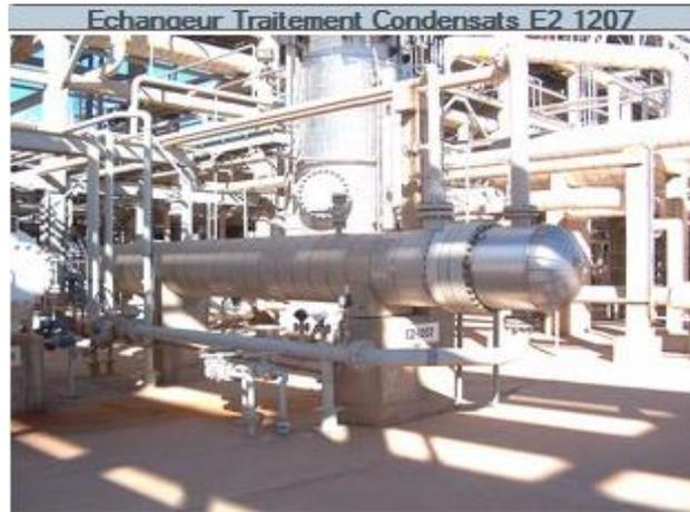
Figure 4 – 7 Photo réel de l'échangeur traitement de condensat
