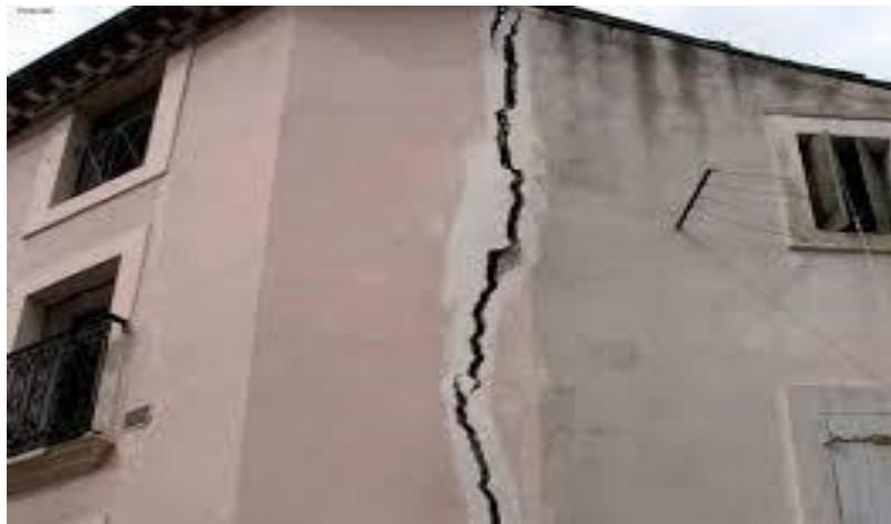
**Figure 1. 9 :** Fissures au niveau d'une structure de génie civil (Zoubir. 2009)
