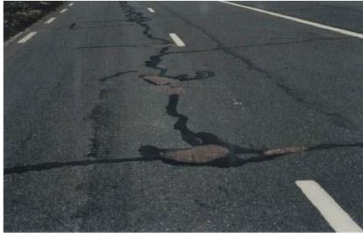
**Figure 1.10:** Fissuration d'une chaussée de sol instable (TP. 2007)
