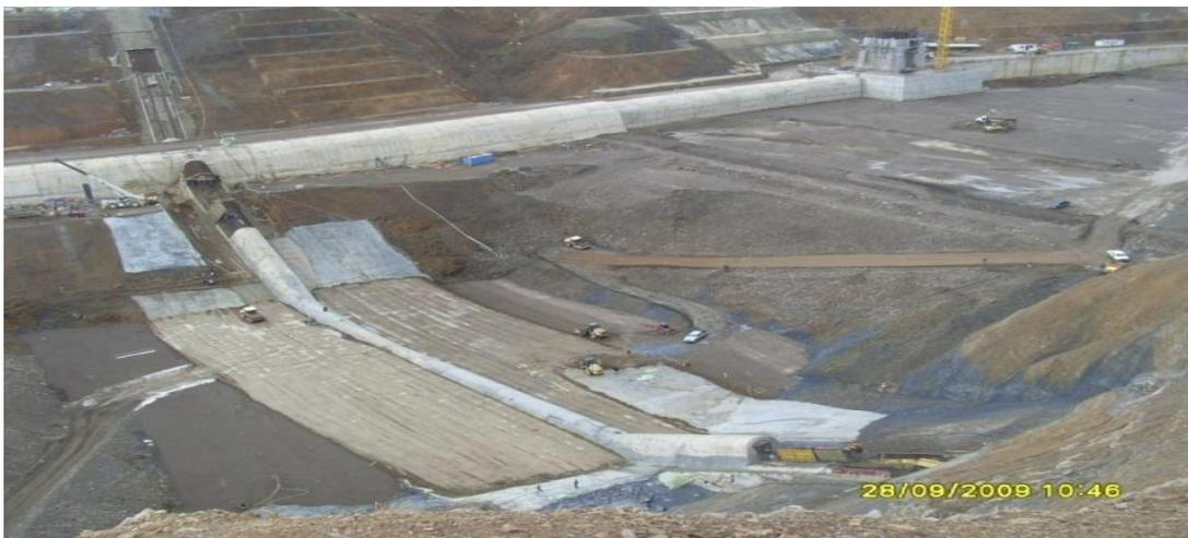
Figure1. 15 : Stabilisation par compactage de surface (Cas d'une digue de barrage en terre de Kef-Eddie construit à Tipaza, Algérie). (Gadouri 2017).
