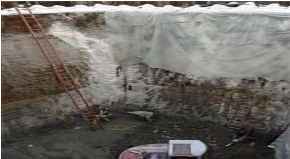
**Figure 1.11:** La stabilisation provisoire des parois d'un fond par la technique de congélation (Gadouri2017).
