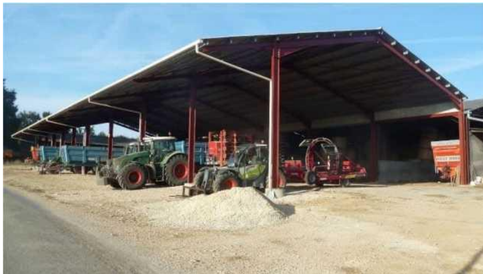
Figure 36 : Hangar des engins et matériels.
