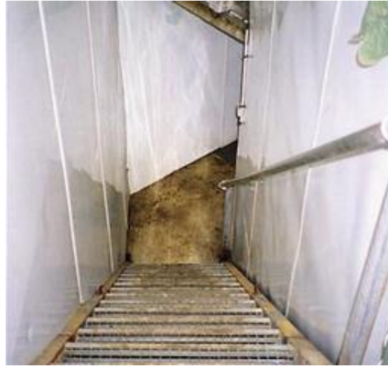
Figure 28 : L'accès à l'intérieur d'un roto-herringbone par un tunnel. (BILLON et al , 2009)
