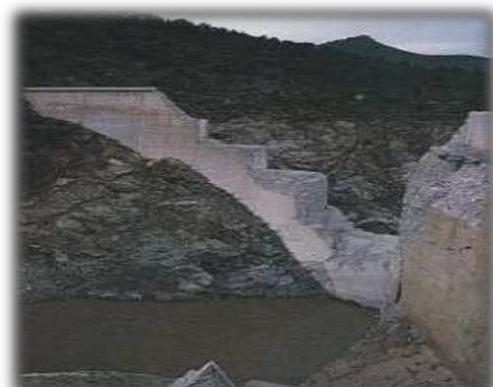
**Fig I-17:**Barrage Malpasset avant (a) et après (b) sa rupture (Schleiss A.J. et Pougatasch H. 2011).
