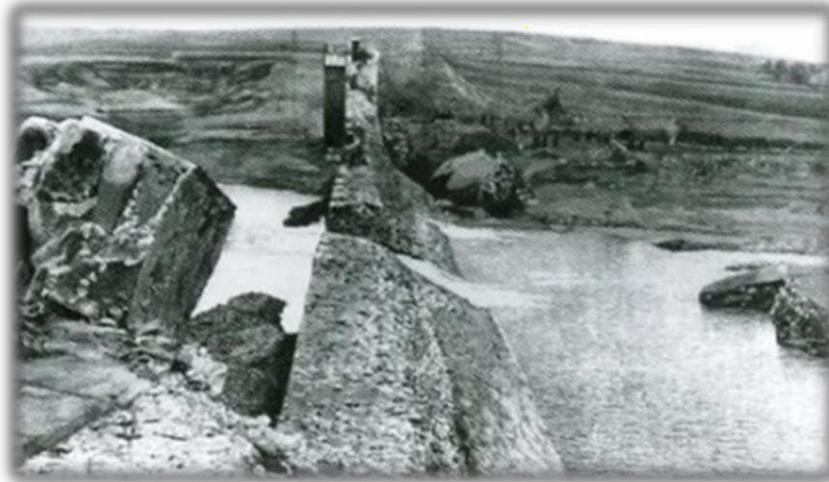
Fig I-19:La rupture du barrage de Bouzey (Deroo L.2011).
