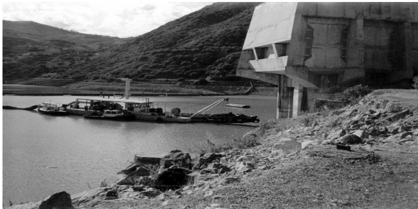
Fig.IV.10 :(a) liste des barrages envases, (b) Drague suceuse au cours du dévasement de la retenue de Zardezas (Rezoug.y, 1997).
