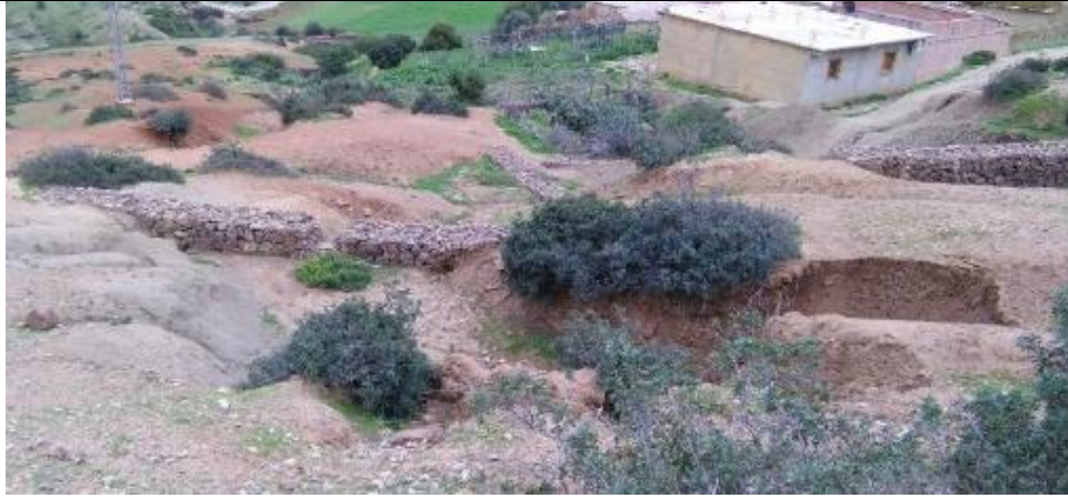
Fig.IV.6 : technique des seuils en gabions (cliché Bettassa et Tafiani, 2018)
