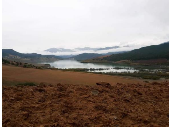
Photo. II.5 : Le barrage de Deurdeur (Anbt,2022)
