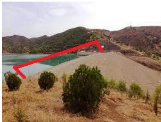
Fig.IV.12 surélévation proposée pour barrage SMBT
