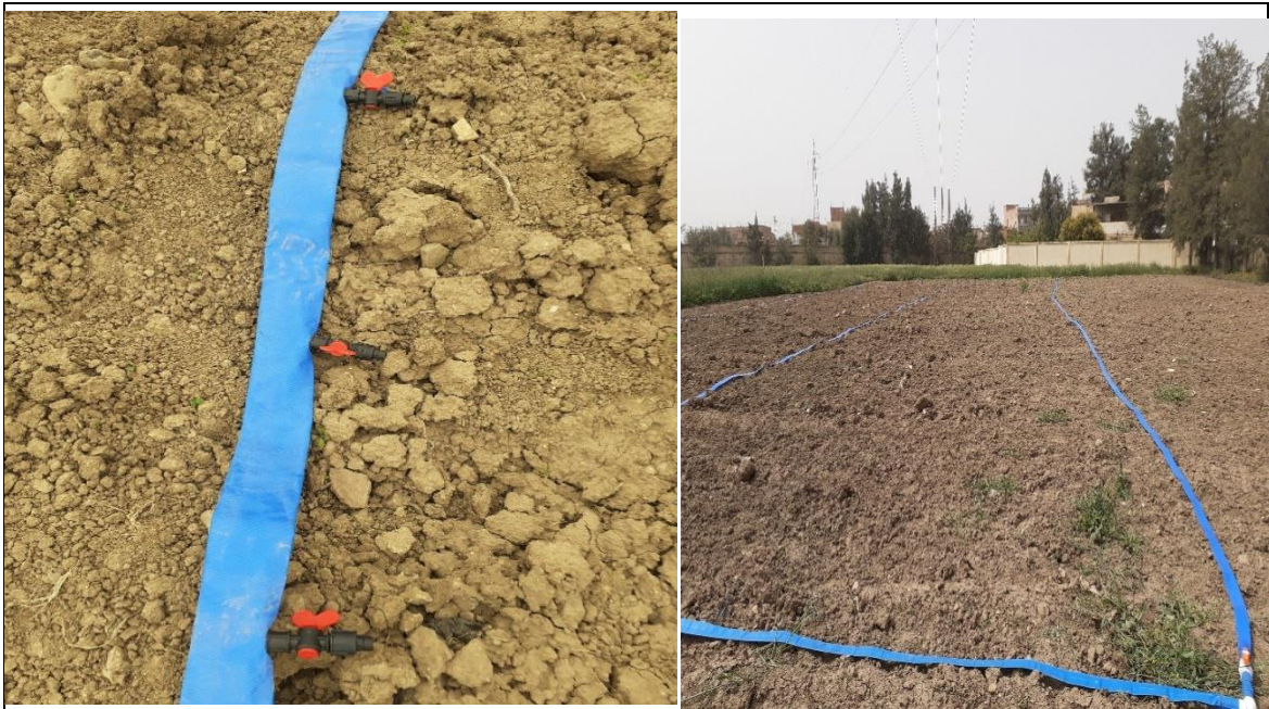
Figure 07 : Installation de réseau d'irrigation ( Hadouche et Semai 2022)
