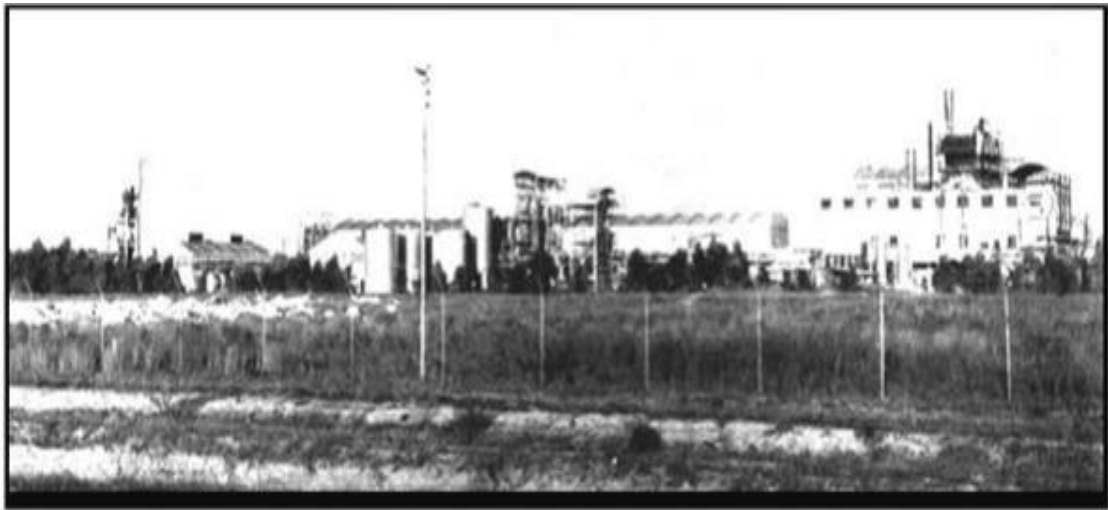
Figure13 : Usine de pâte cellulosique de Sidi-Yahia-du-Rharb (Unasyuva, 1963)
