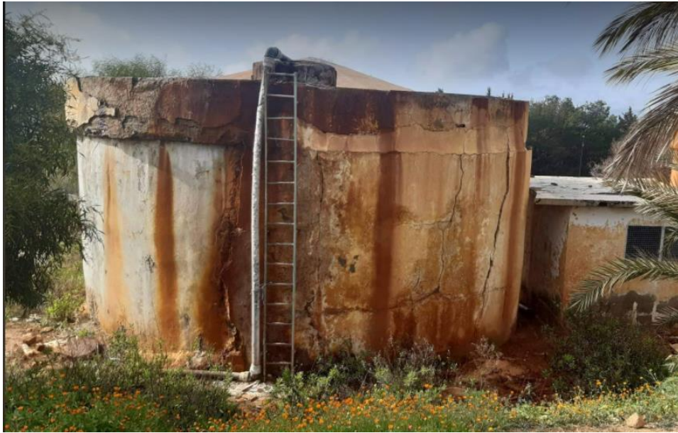
Figure 7 : Forage de Hammam Righa (photo personnelle).
