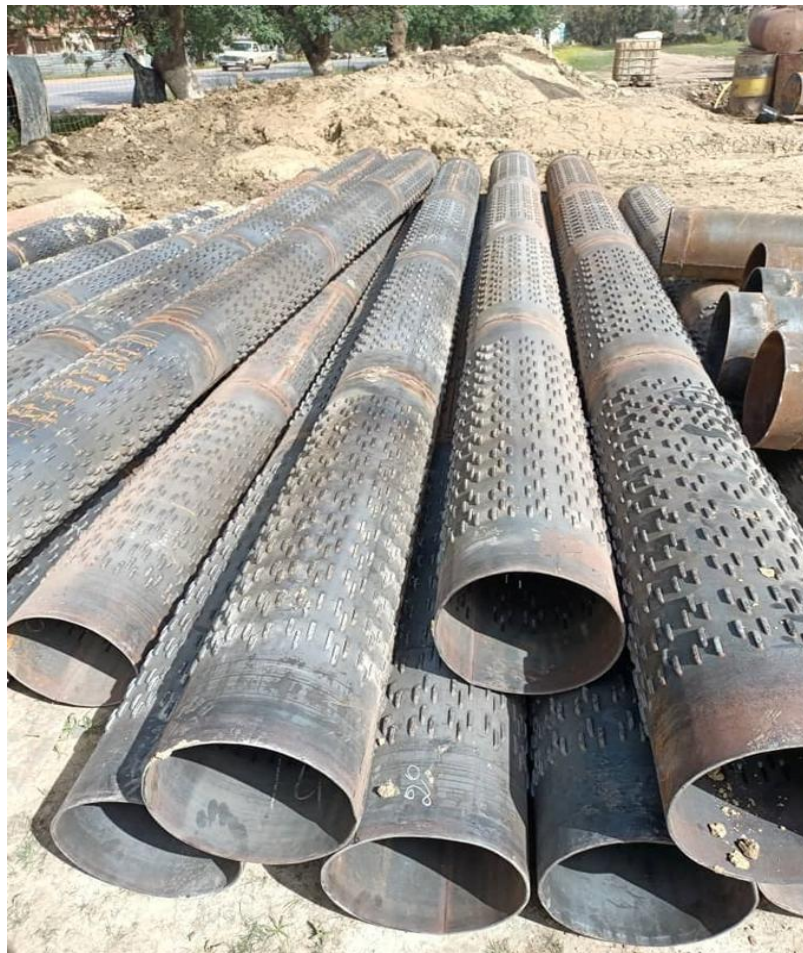
Figure II-13 : tubage du forage (photo pris sur le chantier).
