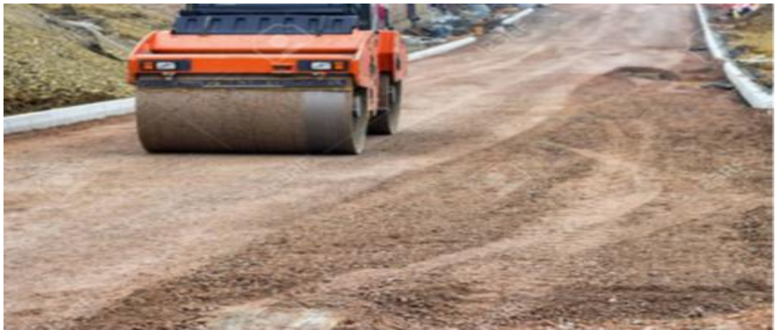
Figure 1.11 - Compactage de surface aux références de compactage d'une chaussée routière.
