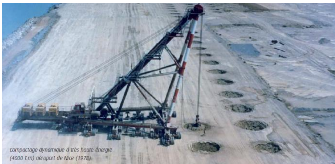
Figure 1.12 - Densification d'un terrain par compactage dynamique à très haute énergie (4000 T.m) (Cas réel de l'aéroport de Nice 1978, France). (Gadouri, 2017).
