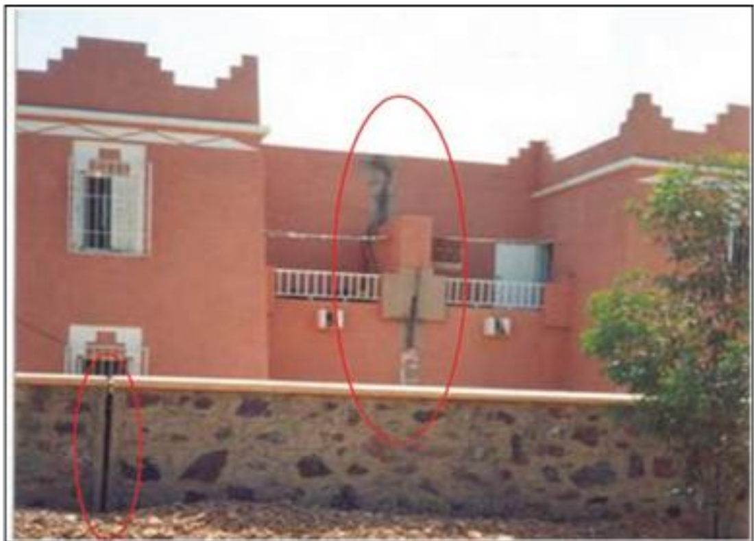
Figure 1.6 - Dommages structuraux dus au soulèvement de terrain (Cas du Maroc).
