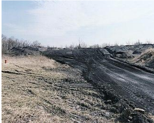
Figure 1.17 Chantier de traitement du sol à la cendre volante
