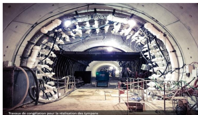
Figure1.14 les terrains solidifiés grâce à la congélation des sols
