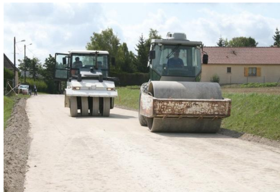
Figure1.9 Compactage des couches d'assise de chaussée
