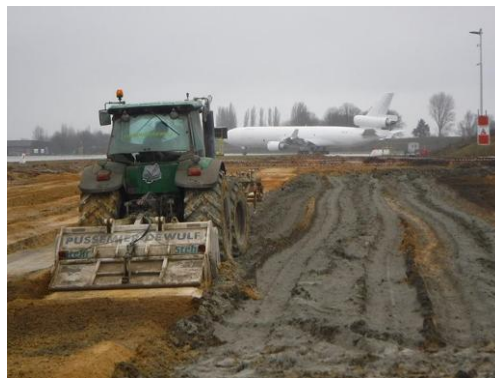
Figure1.16 Chantier de traitement du sol au ciment
