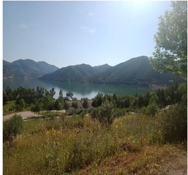
Figure.II.8 : la retenue du barrage de SMBT.
