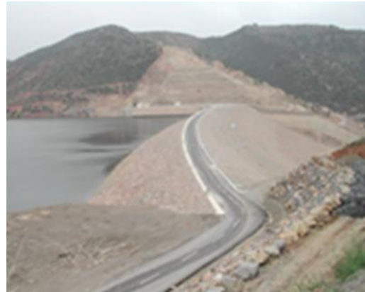
Figure.II.6 : La digue de barrage deSMBT.
