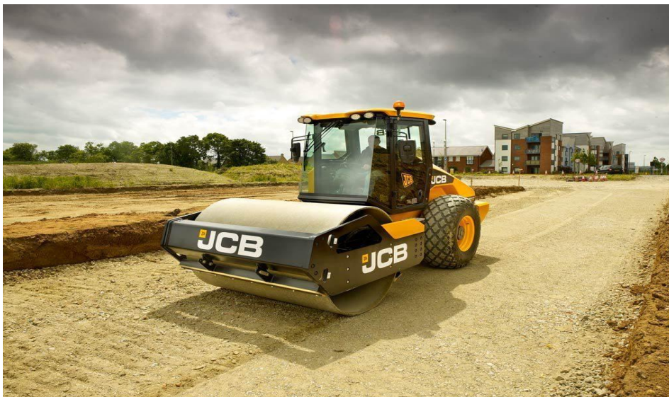
Figure 1.10 : Amélioration par la technique de compactage de surface.
