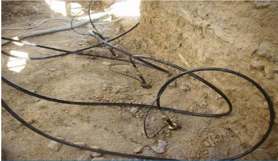
Figure 1.18 : installation des injecteurs dans le sol.
