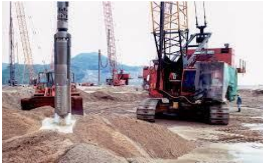
Figure 1.12 : Amélioration par la technique de Vibrocompactage.
