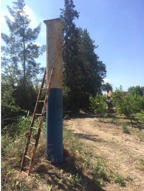
Figure III-1 Piézomètre et escabeau utilisé
