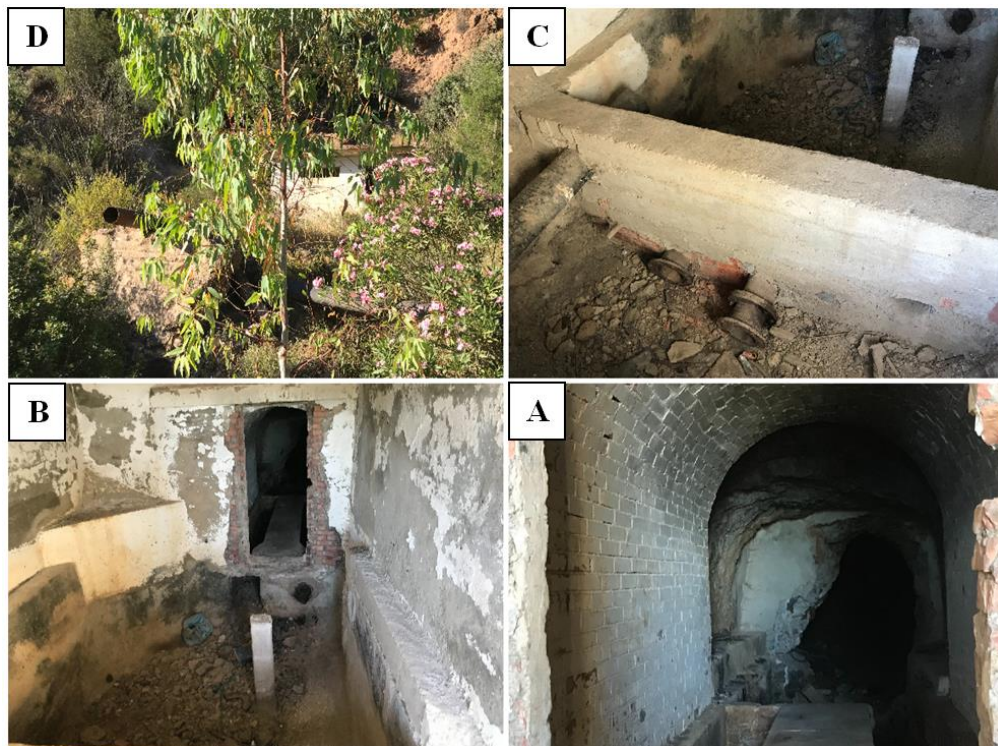
Figure V-5 Photos de la nouvelle source aux mines de l'oued Rihane; A) entrée de la galerie de mine ; B) émergence de la source ; C) bassin de stockage ; D) tuyau d'alimentation.
