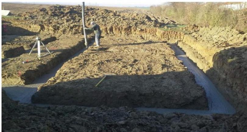
Figure I-14 : Coulage d'un béton de propreté en fond de fouille d'une fondation.
