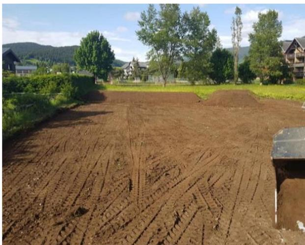
**Figure I-12** : Préparation de chantier et décapage de la terre végétale.
