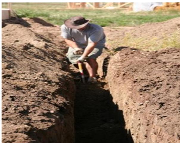
**Figure I-13** : Creusement d'une tranchée pour fondation semelle filante.
