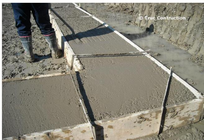
Figure I-16 : Coulage du béton dans les tranchées de fondation.
