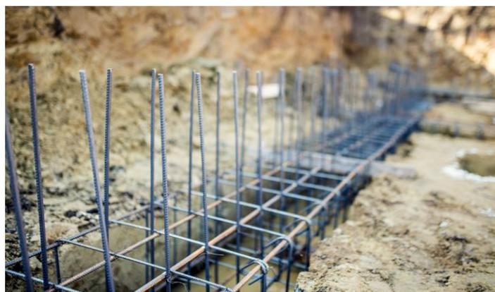
Figure I-15 : Ferraillage d'une semelle filante
