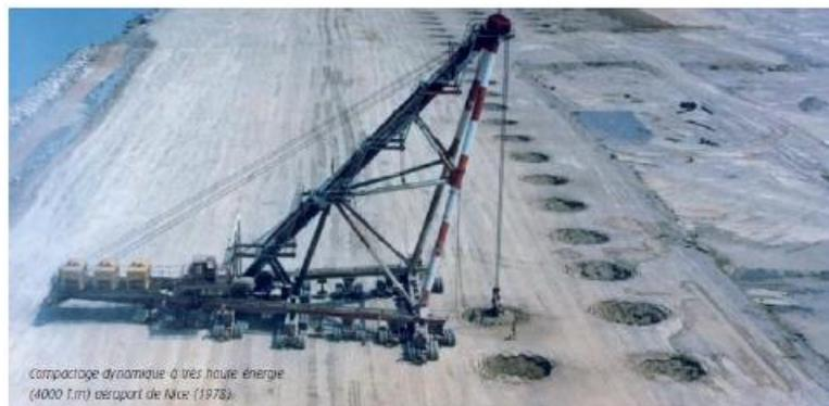
**Figure** Erreur ! Il n'y a pas de texte répondant à ce style dans ce document.-13 **Densification d'un terrain par compactage dynamique à très haute énergie (4000 T.m) (Cas réel de l'aéroport de Nice 1978, France). (Gadouri, 2017)**
