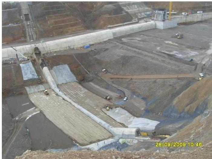
**Figure** Erreur ! Il n'y a pas de texte répondant à ce style dans ce document.-11 **Stabilisation par compactage de surface (Cas d'une digue de barrage en terre de Kef-Eddir construit à Tipaza en 2009, Algérie) (Gadouri, 2017)**
