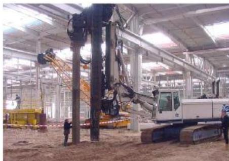
**Figure** Erreur ! Il n'y a pas de texte répondant à ce style dans ce document.-15 **Densification par vibro-compactage (Cas d'un sable lâche ayant 5m d'épaisseur d'un hall industriel construit en Belgique).** (Gadouri, 2017)
