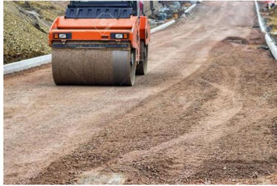
**Figure** Erreur ! Il n'y a pas de texte répondant à ce style dans ce document.-12**Compactage de surface aux références de compactages d'une chaussée routière.**
