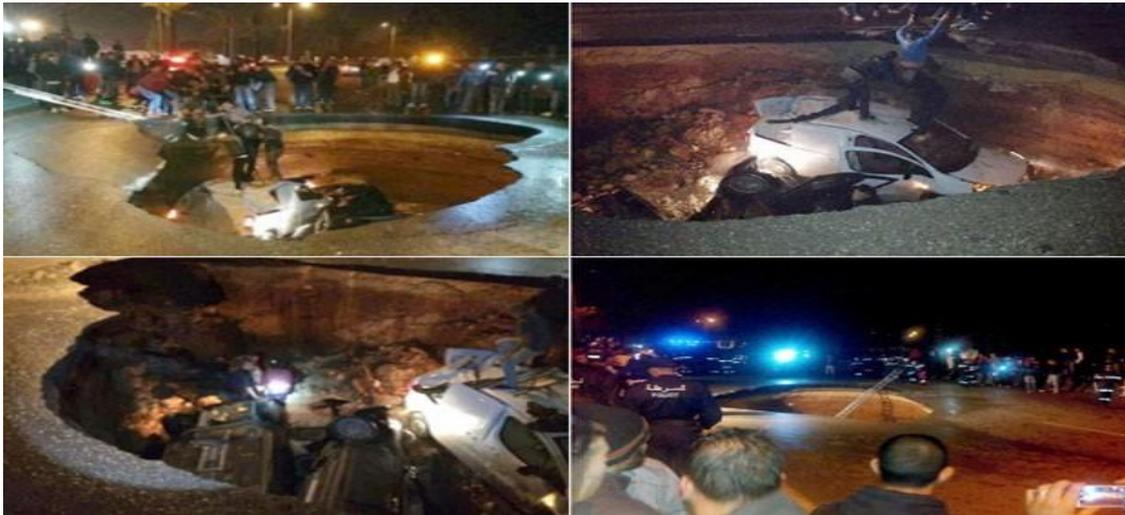
**Figure 1.5-** Effondrement de terrain de 10 mètres de profondeur et de 20 mètres de largeur survenu le 18 Novembre 2016 à Alger de l'autoroute reliant Ben Aknoun et Zeralda (**Meziani, 2018**).
