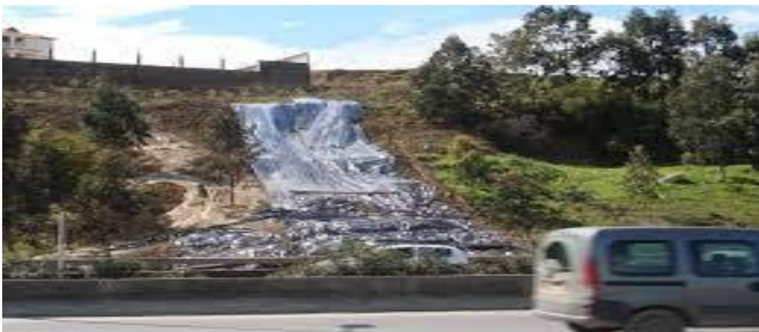
**Figure1.7** Un glissement de terrain sous forme d'une coulée de boues des grands vents sur la rocade d'Alger (Arab et al, 2009).
