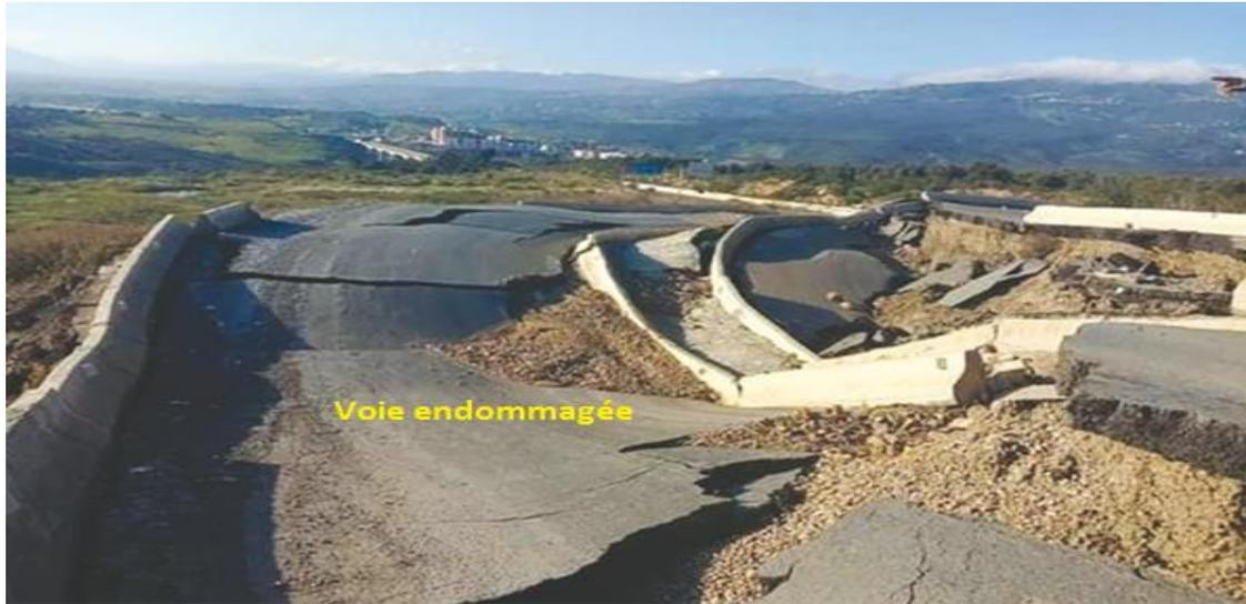
**Figure 1.9-** Un glissement de terrain endommage la route d'Azazga (Oukaci,2019).
