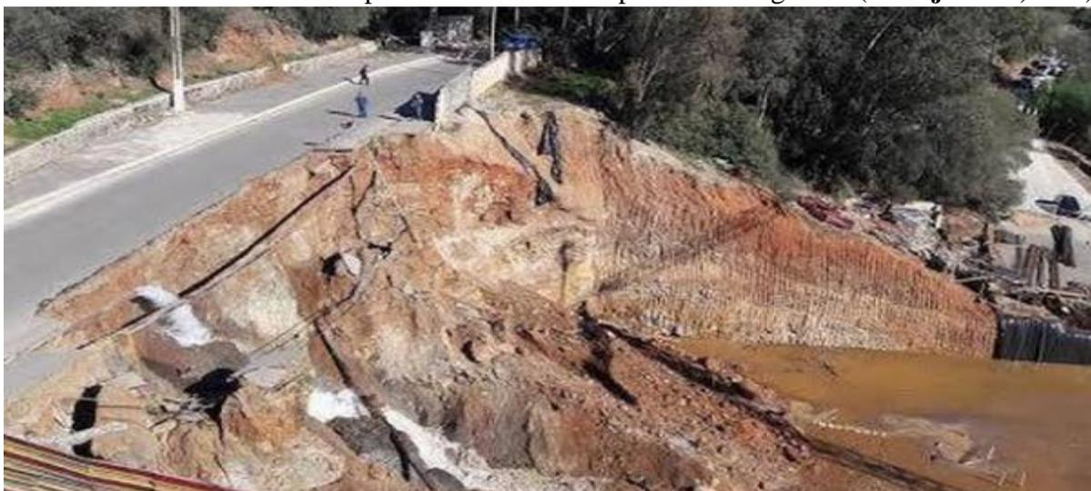
**Figure1.15-** Un glissement de terrain à l'origine de la fermeture d'une route (Bouzaréah)(**Live News Algérie,**
