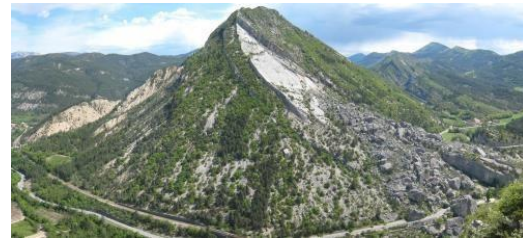
Figure 1- 4: Glissement plan survenu dans la commune de Luc en Diois dans le département de la Drôme suite à un séisme survenu en 1442 (Glissement plan classé en 2014), (Source : Géosciences et Archéologie en Pays d'Oc) (Meziani, 2018).
