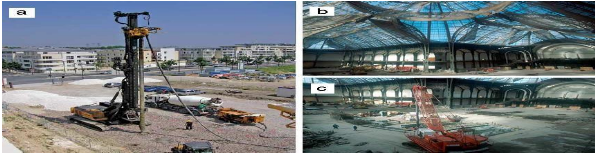
Figure 1- 16: Renforcement du sol en place. a) Inclusions rigides (Source: Photothèque Keller) b et c) Renforcement des fondations du grand Palais (Photothèque Solétanche Bachy).
