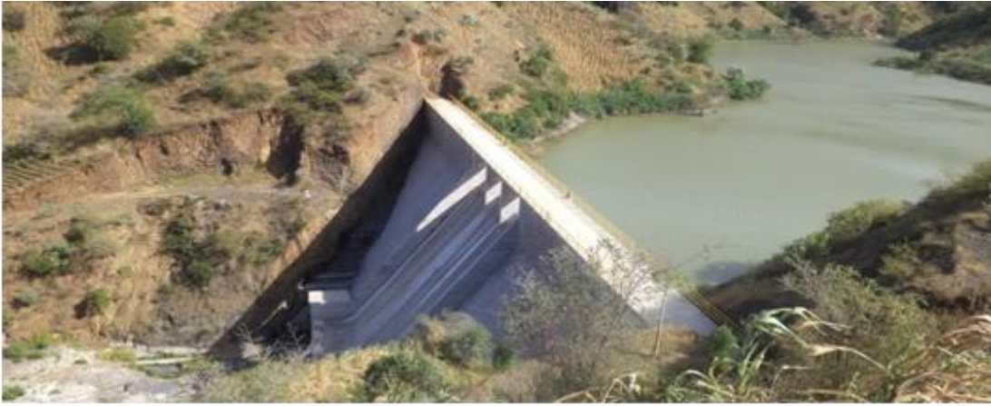
Figure 43 : Ouvrages hydrauliques et Barrages (Iha de Santiago, Cabo Verde 2013).
