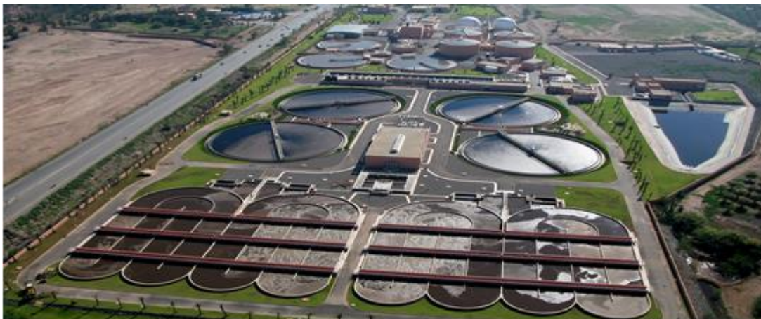
Figure 38 : station d'épuration des eaux usées destinées à l'irrigation (Marrakech, Maroc).
