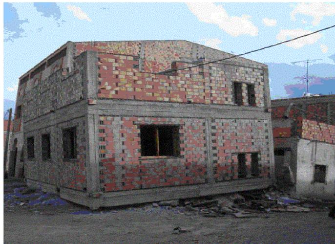
Figure 2.5. Contreventement par maçonnerie.
