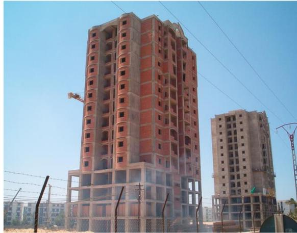
Figure 2.7. Contreventement mixte d'un bâtiment.
