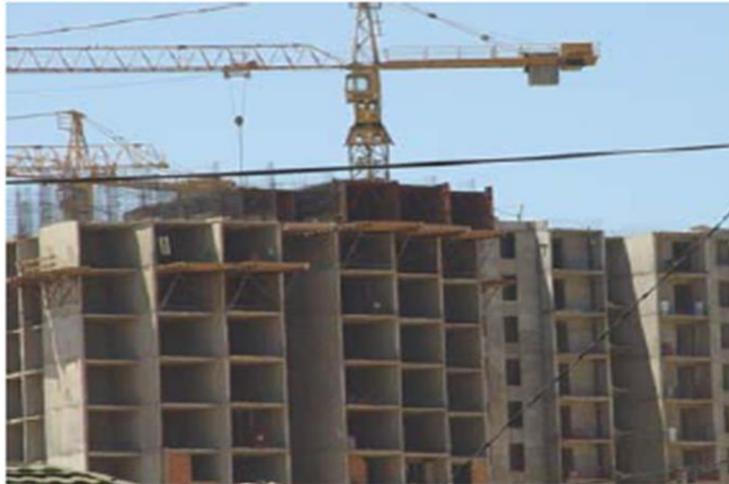
**Figure 2.3. Contreventement par voiles en béton armé.**
