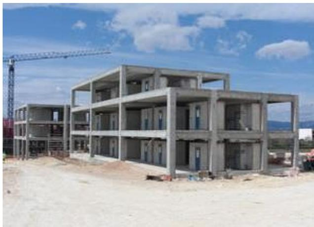
Figure 2.1. Ossature en portiques en béton armé.
