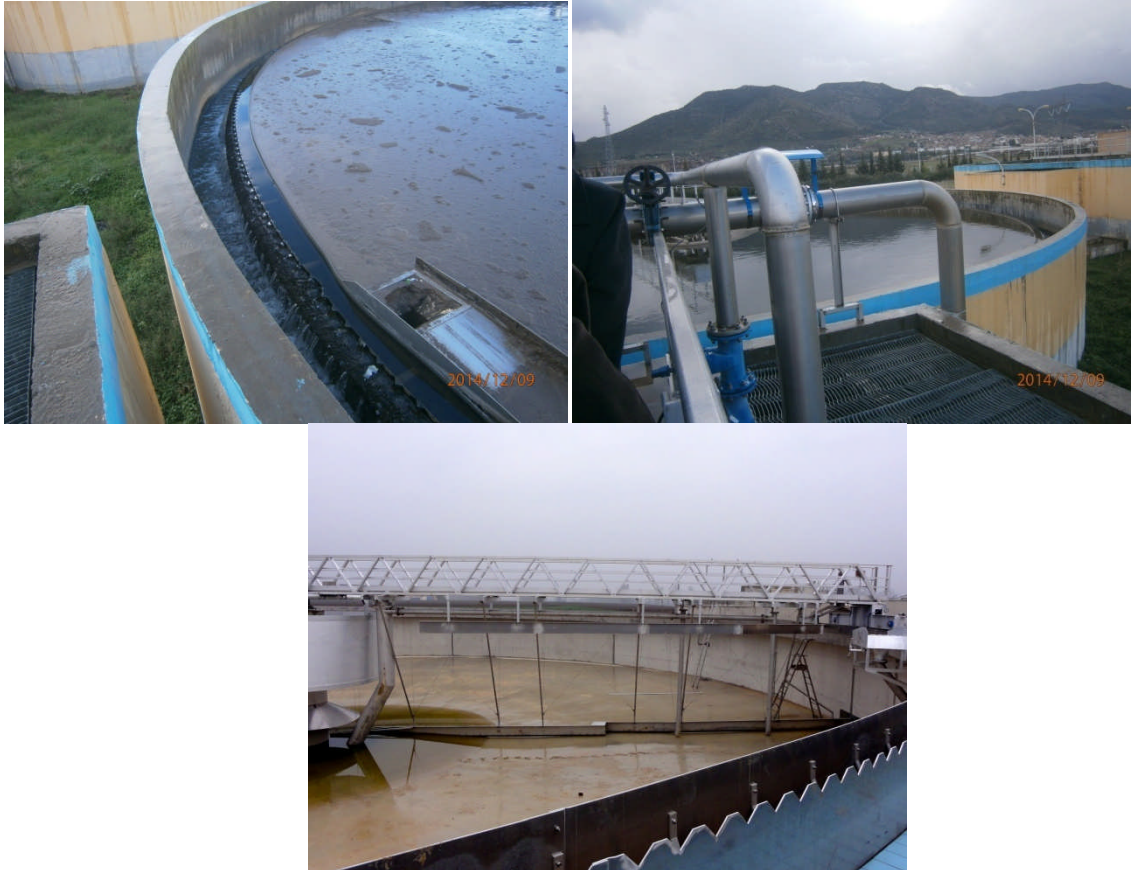
Photo 05: clarificateur dans la STEP de Ain Defla. (Source Touhari)
