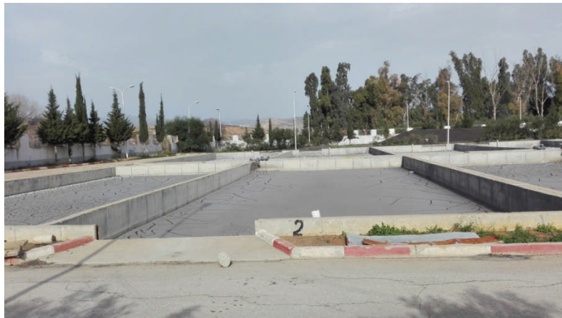
Photo 08: Lits de séchage dans la STEP de Ain Dfela. (Source Touhari)
