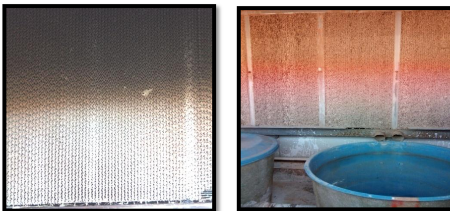
Photo N°11 : Pad cooling (photo personnelle).
