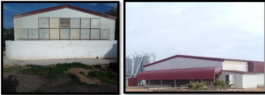
Photos N°3 : Murs et toitures des bâtiments visités (photo personnelle).
