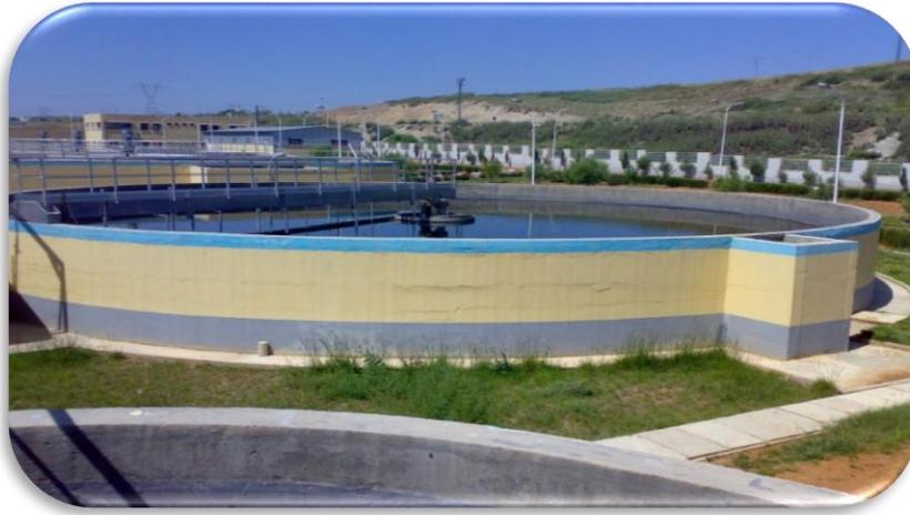
**Figure n°5 :** décanteur (clarificateur) de la station d'épuration de la ville d'Ain Defla.
