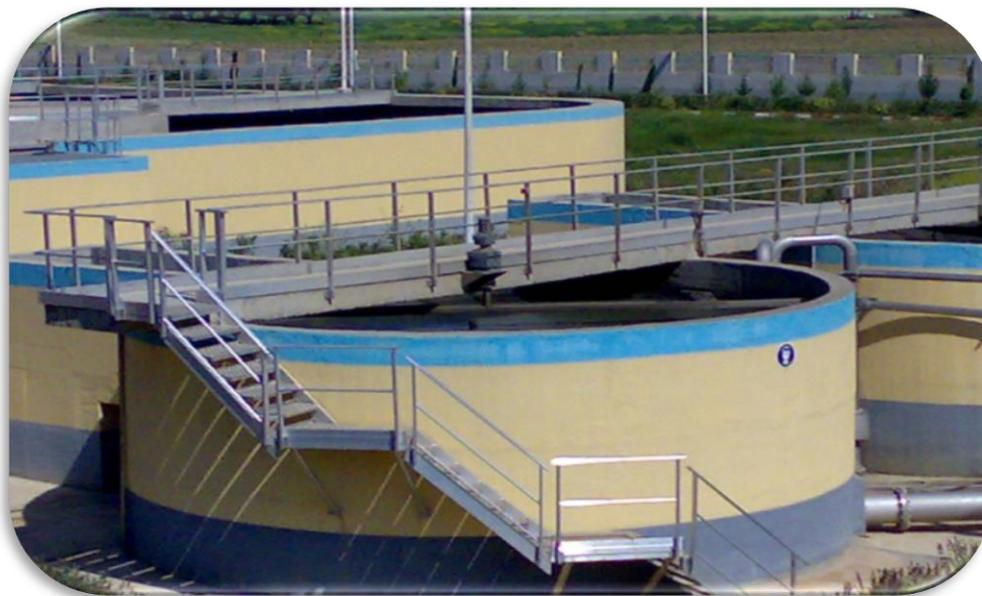
**Figure n°1** : déshuileur et déssableure de la station d'épuration de la ville Ain Defla.
