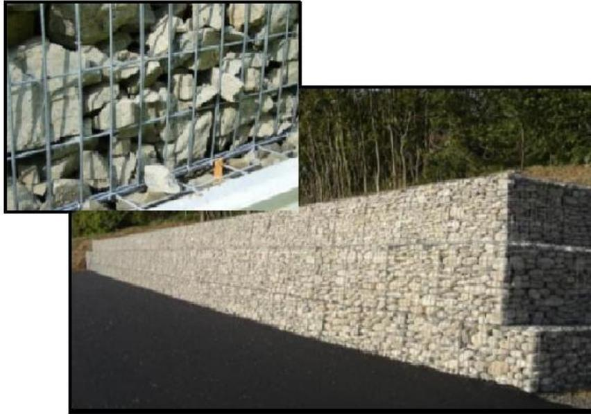
Figure 3.9 : Gabions électro soudés
