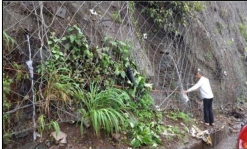
**Figure 3.5 :** tuyaux de drainage installés à l'autoroute Mumbai-Pune (hauland)
