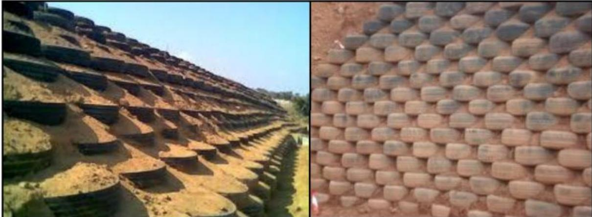
Figure 3.12 : la technique de mur pneu/sol
