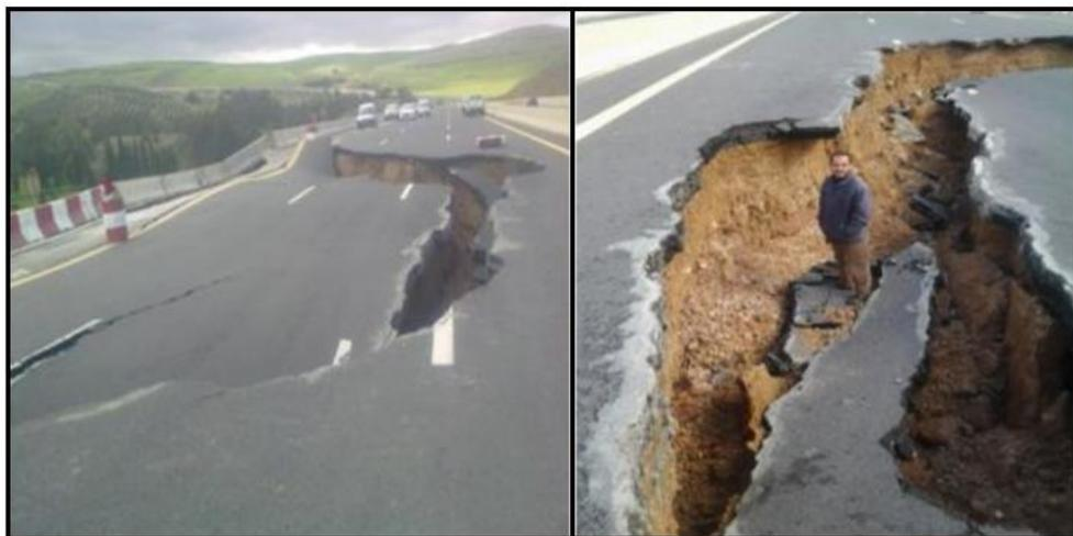
**Figure 1.16 :** glissement de terrain de Tlemcen en 2014 (Bourdim et al., 2018).
