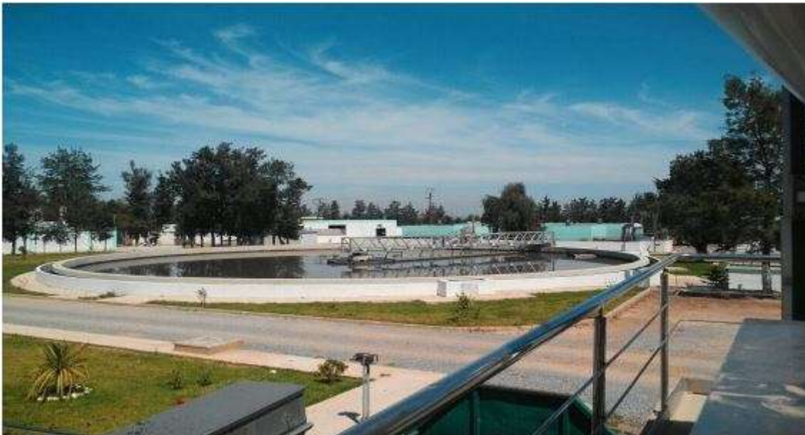
Figure III.1 : image d'un Bassin d'Aération de la STEP (rapport OTV,2019)
