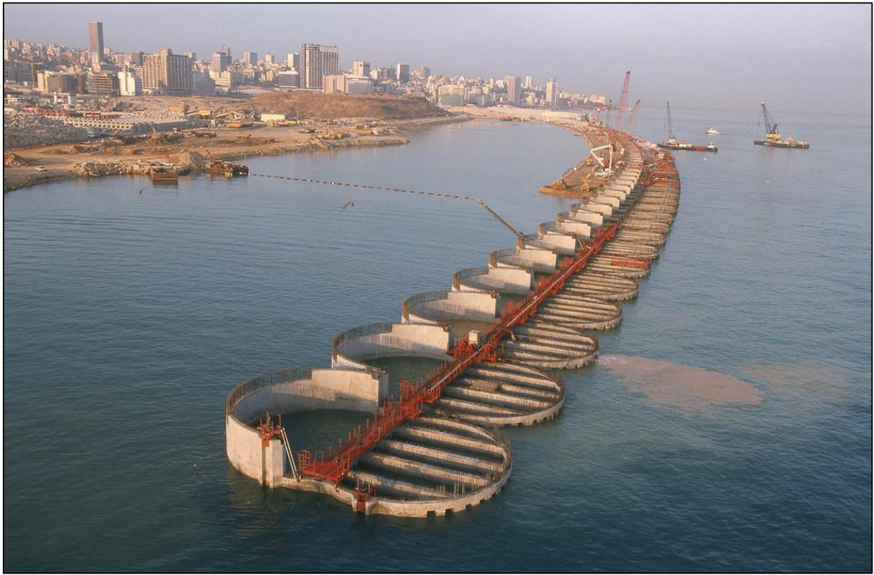
**Figure I.4** : caisson de front de mer de Bierut [id : 228275] (Boygue Construction, 2000).
