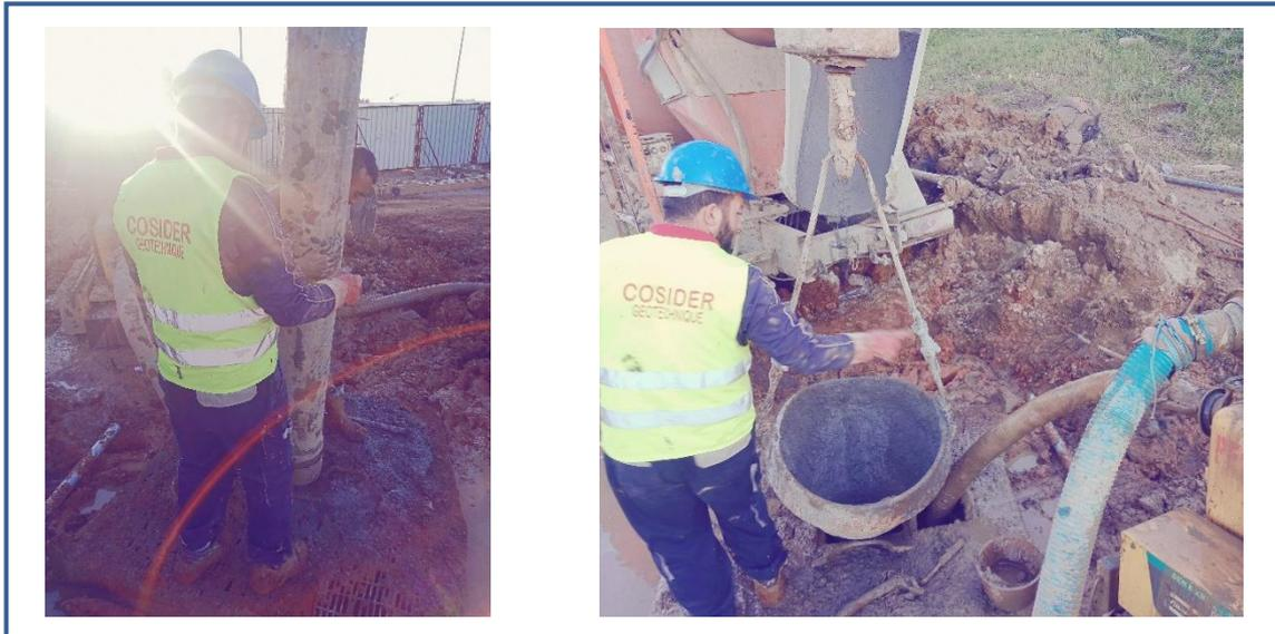
**Figure A.9 :** La mise en place de la colonne bétonnage
