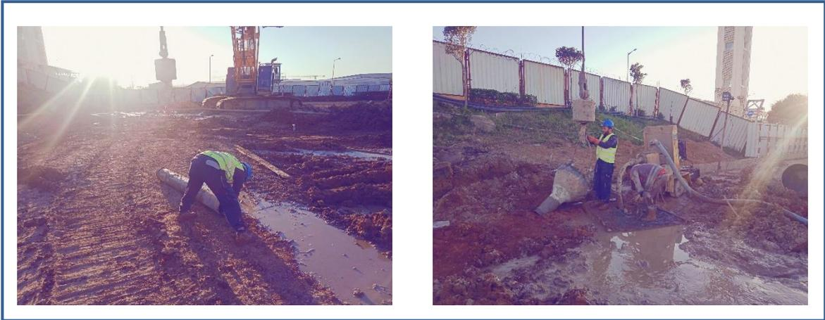
**Figure A.11** : Retrait de la colonne bétonnage.
