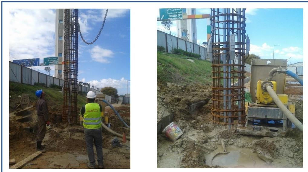
**Figure A.8 :** La mise en place de la cage d'armature.
