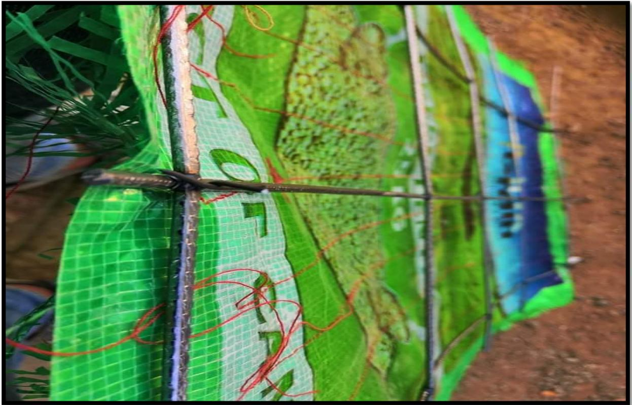
**Figure 10** : dispositif d'ancrage formé par un tri-soudé et un gazon synthétique (original,2020)
