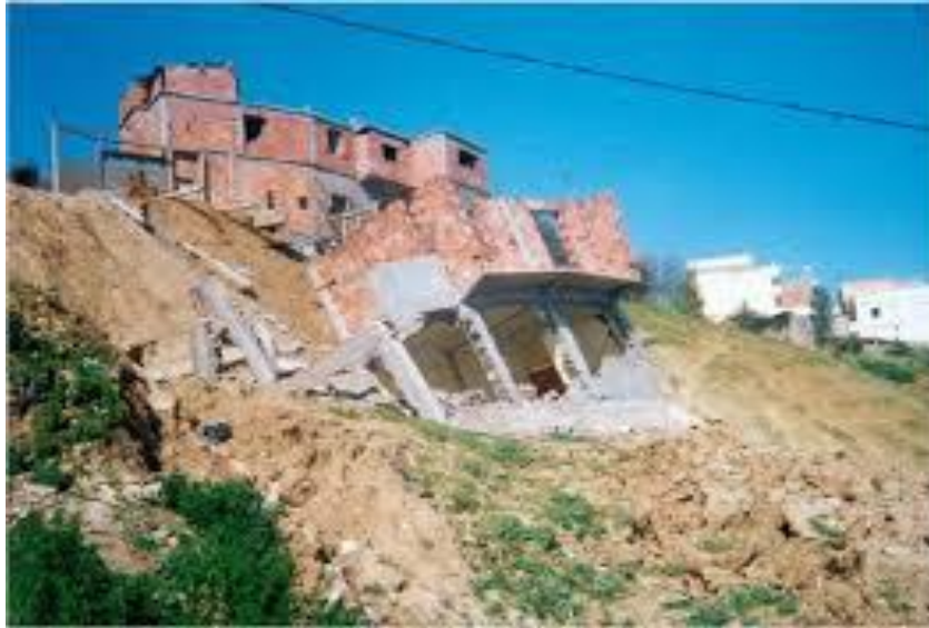
Figure I-19: Glissement de Tizi quartier de Bejaia. Basculement d'une habitation
