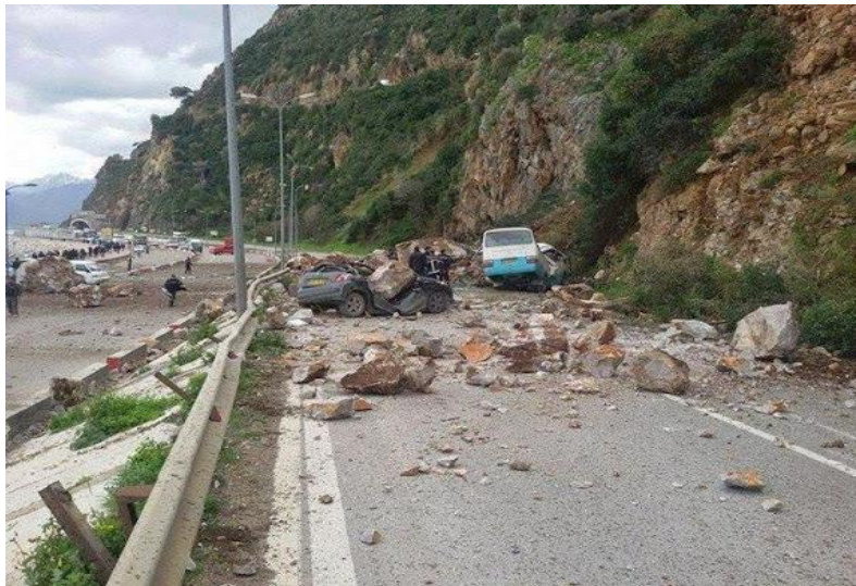
Figure I-1: Chutes de blocs à Bejaïa (aokas ) (Kanouni et Bacha,2019).
