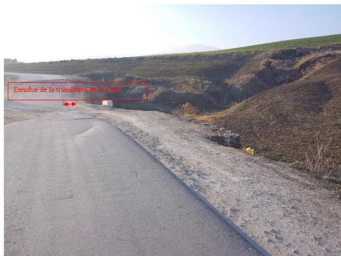
**Figure 2.18:** Photo montrant l'abaissement du niveau de la route et la translation visible de l'axe de la route dans le sens de la pente du talus [28].
