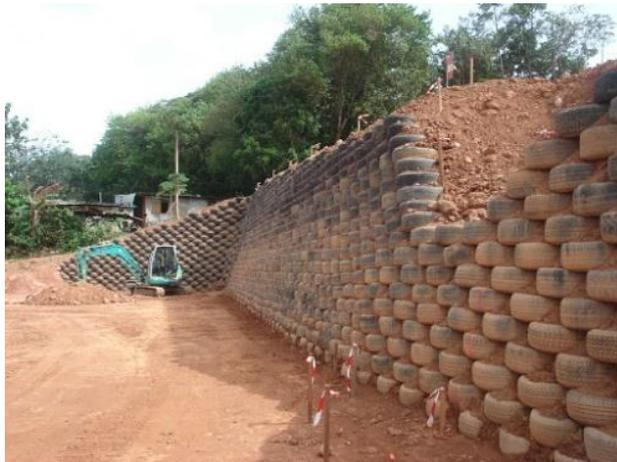
**Figure 1.39:** Renforcement par pneusol.
