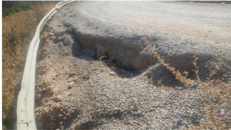
**Figure 2.23:** Aperçu sur l'affaissement au niveau de l'accotement [28].
