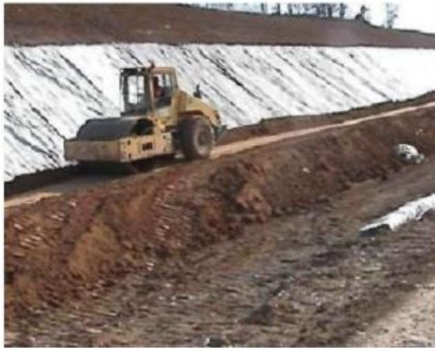
**Figure 1.34:** L'utilisation du géotextile en jouant un double rôle: le drainage et le renforcement du talus.
