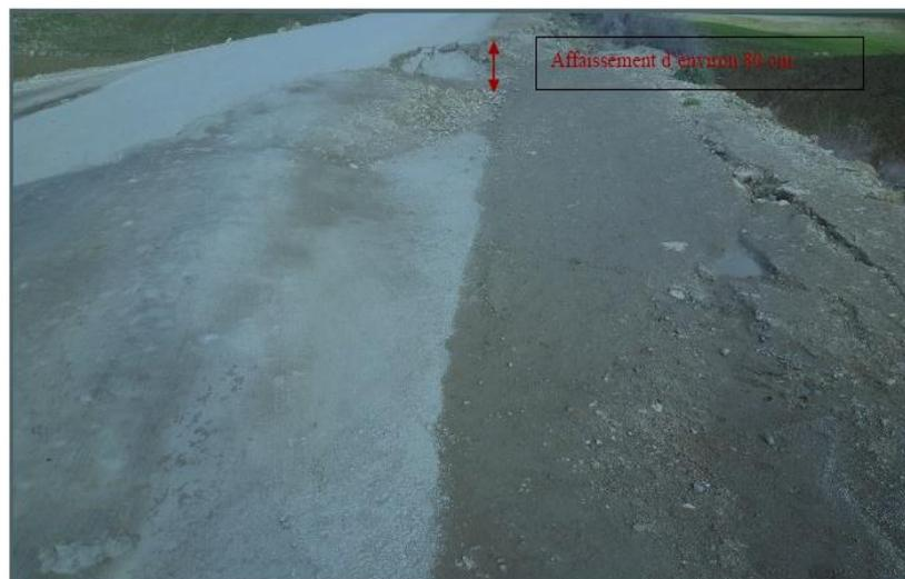
**Figure 2.16:** Aperçu sur l'affaissement dangereux sur les usages d'environ 80 cm observé au niveau de la route [28].
