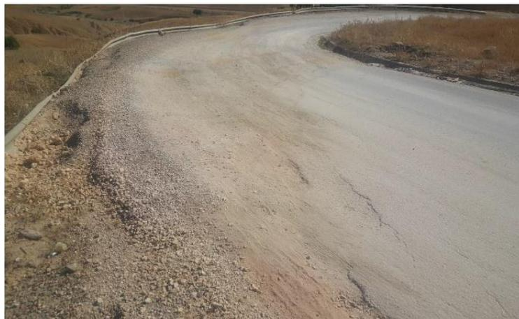
**Figure 2.22:** Aperçu sur le glissement au CW32 PK 02+500 [28].
