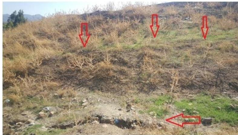
**Figure 2.24:** Aperçu sur le ventre apparent au-dessous ainsi une fissure causée par les venus d'eau [28].
