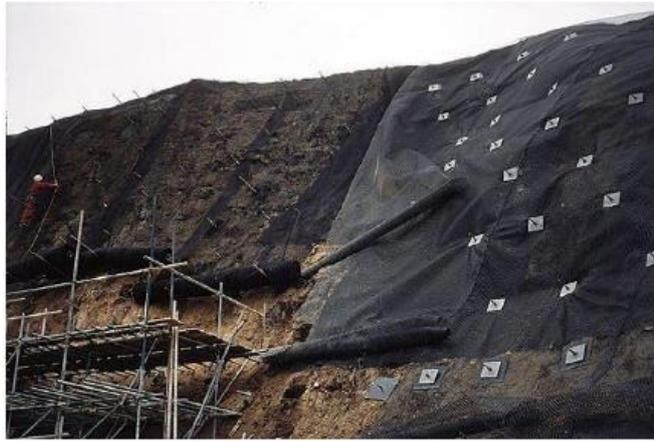
**Figure 1.33:** Un versant stabilisé par clouage.
