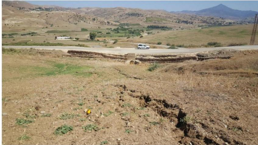
**Figure2.19:** Aperçu sur l'érosion causée par les crues côté amont de la route [28].
