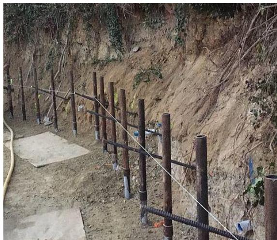
**Figure 1.35:** Installation de micro-pieux.
