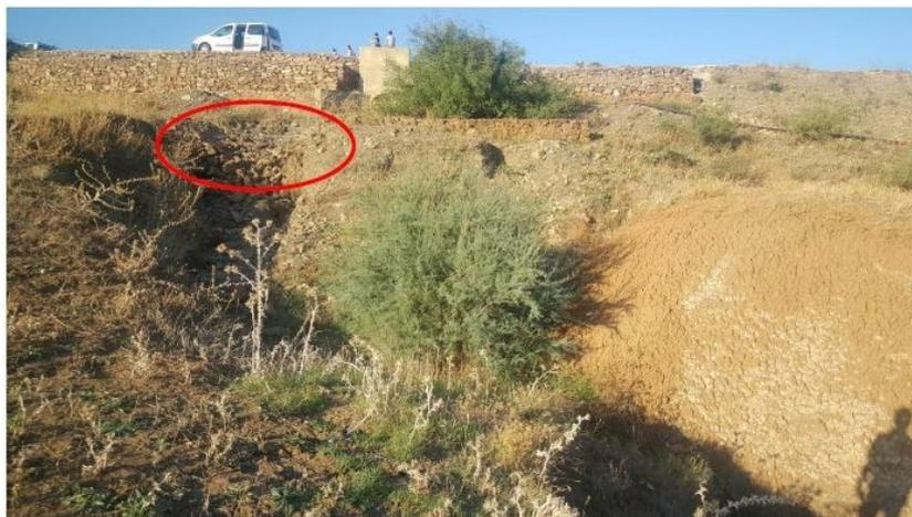
**Figure 2.20:** Aperçu sur l'effondrement partiel du seuil en gabion côté aval [28].
