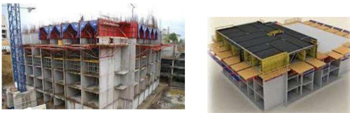
Figure I- 2 : Un aperçu du technique coffrage tunnel sur chantier
