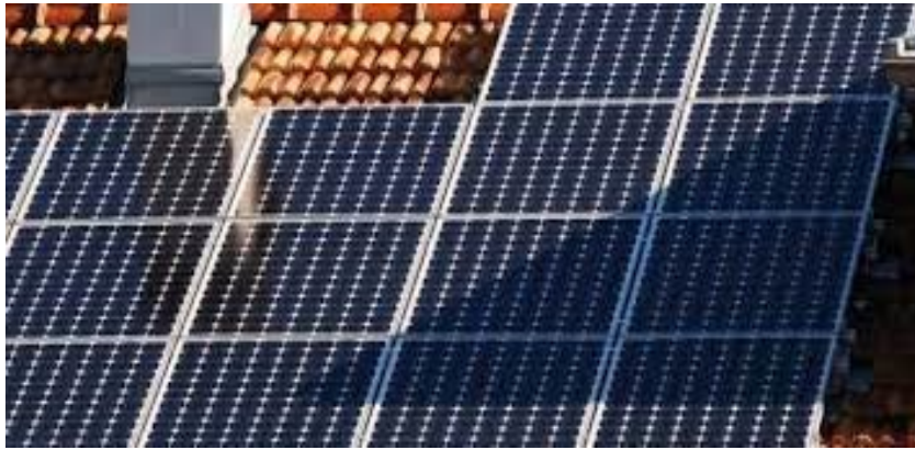
Figure I-30 : Panneau photovoltaïque sous ombre partielle causée par une construction.
